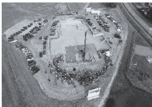
► Het slaan van de eerste paal voor het nieuwe kerkgebouw in Kesteren.
