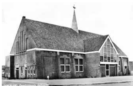
De verbouwde kerk aan de Geldersedijk (1966)
